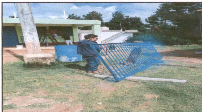
Foto 4: Ventanas sustitución de balcones de metal
