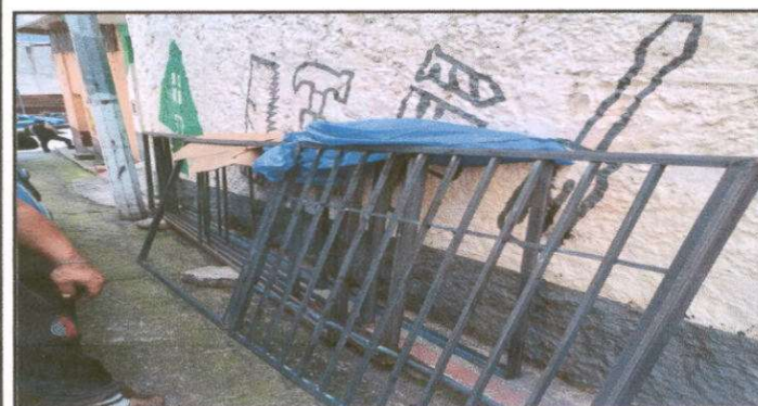
Foto 5: Sustitución de muro perimetral
