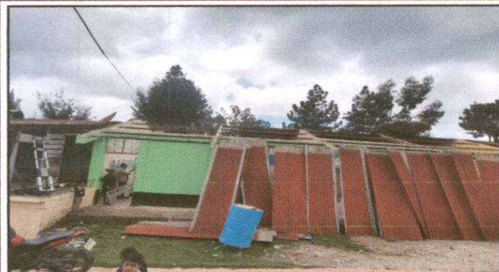
Foto1: Sustitucion de lámina por lámina troquelada calibre 26 Escuela
