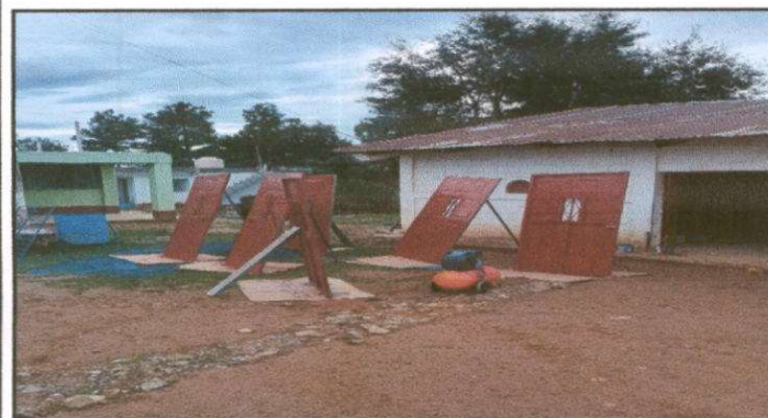
Foto 3: Sustitución de puertas en mal estado por puertas de metal
