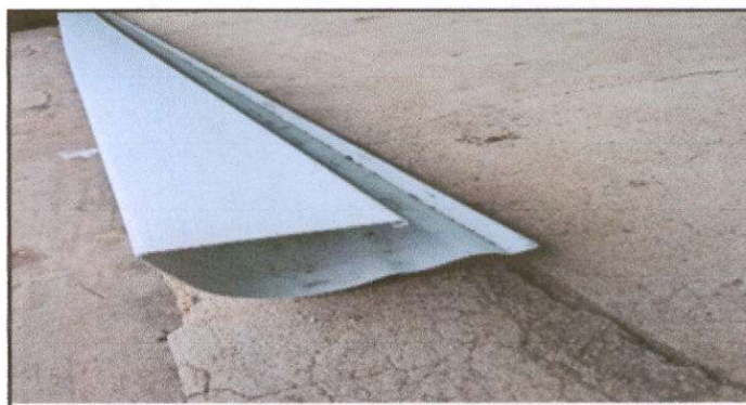
Foto 6: Sustitución de canales y bajadas de agua pluvial
